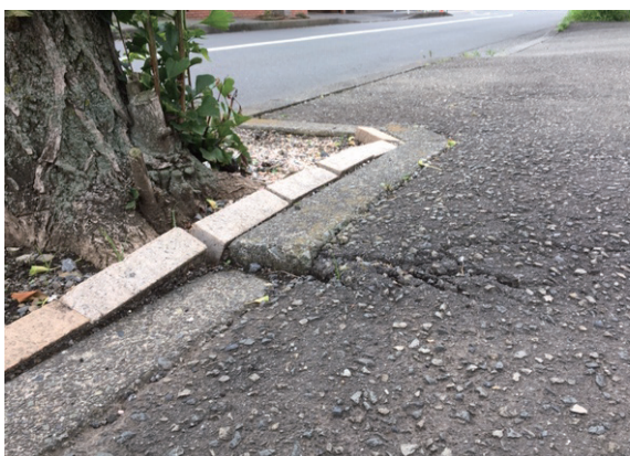
▲根止り材を敷きつきの歩道
